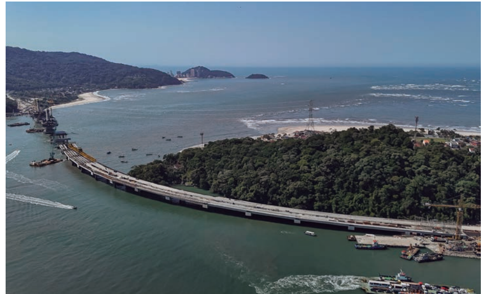
Obra da Ponte de Guaratuba movimenta a economia do Litoral
